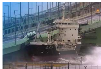
連絡橋に衝突したタンカー
