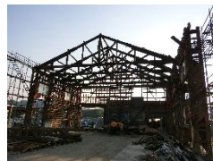
↑解体半分完了！
