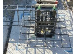
↑鉄筋配筋助教
