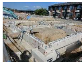
↑地中梁コンクリート
